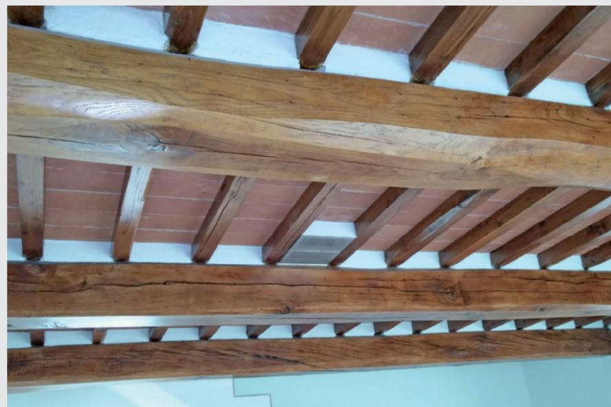
**4. IL POSIZIONAMENTO** delle bocchette è condizionato dalla tipologia costruttiva dell'immobile, caratterizzato da solai in travi e travicelli in legno con mezzane in laterizio.
