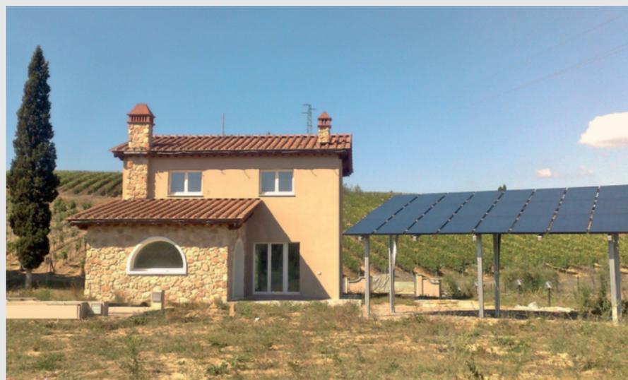
**3. LA PENSILINA SOLARE** ha una superficie di 33 m<sup>2</sup> di pannelli fotovoltaici per la produzione di 5,52 kWp.
