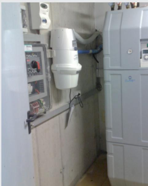
**1. LA POMPA DI CALORE** condensata ad aria, con potenza termica nominale in riscaldamento di 16 kW, dotata di accumulo integrato da 200 l per la produzione di acqua calda sanitaria.
