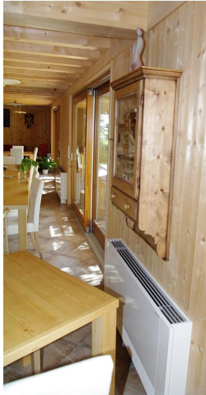
Lavorando con acqua a temperature più basse rispetto ai radiatori, i ventilconvettori permettono inoltre di sfruttare a pieno il potenziale di risparmio energetico offerto dalla pompa di calore, che in questa modalità di funzionamento garantisce la massima efficienza.
