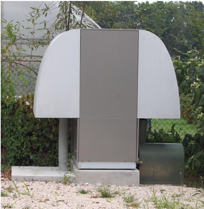
La pompa di calore alimenta due accumuli rispettivamente da 300 litri e 750 litri per l'acqua calda sanitaria ed il condizionamento estivo ed invernale.
